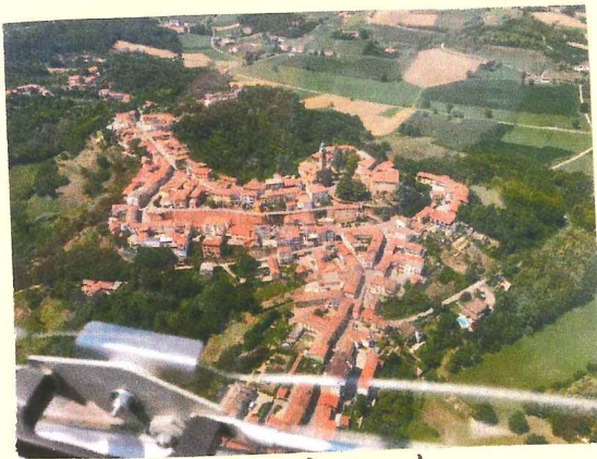
Contreforts du Piémont
